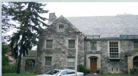
RÉSIDENCE PRIVÉE DU CONSUL DE LA BELGIQUE À MONTRÉAL Refection professionnelle des joints de mortier, injections des pierres fissurées, imperméabilisation des murs de pierres.
